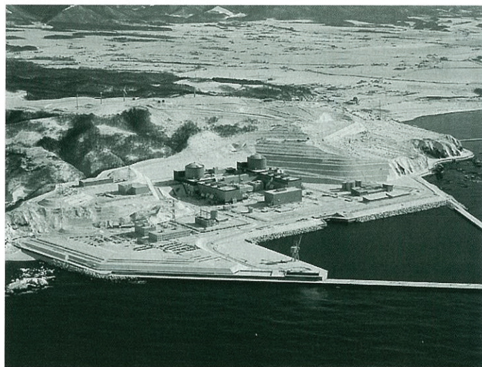
泊原子力発電所
