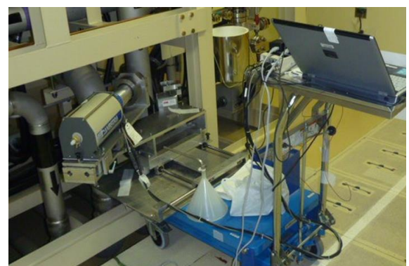
配管濃縮度モニター(*1)
