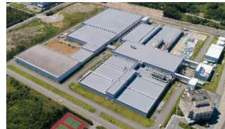
ウラン濃縮工場全景
